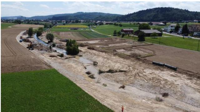
*Abbildung: Die Abfolge des Bauvorgangs ist aus der Vogelperspektive gut zu erkennen: Während der Abschnitt beim Fussballplatz noch begradigt, ist auf Höhe der Baumaschinen die Grobmodellierung bereits erfolgt und im Vordergrund der bereits revitalisierte schlängelnde Gewässerlauf. Rechts auf dem Acker die parallel mit dem anfallenden Aushubmaterial erfolgte Terrainveränderung.*
