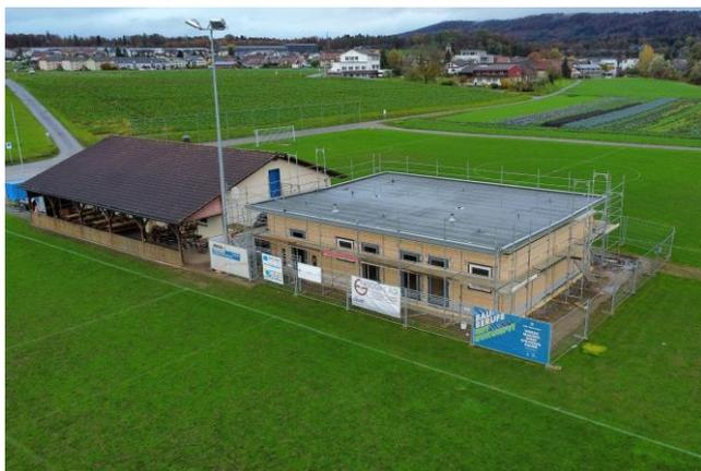
Die Werkleitungserschliessung und der Rohbau konnten gemäss Terminplan realisiert werden. In den vergangenen Wochen wurde das Holzelement-Dach aufgerichtet und die Fenster und Türrahmen verbaut. Bis zum Jahresende stehen nun die haustechnischen Rohinstallationen sowie das Einbringen der Bodenheizung und des Unterlagsboden auf dem Plan. Das Ziel ist es, über den Jahreswechsel mit der Austrocknung starten zu können und im neuen Jahr den Innenausbau zu forcieren.
