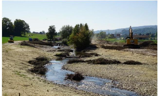
*Abbildung: Blick auf die fertiggestellte Musterstrecke im Sommer 2023. Die Bünz nimmt langsam Gestalt an. Das Gerinne ist abwechslungsreich strukturiert und weist tiefe, flache und schnellfliessende Stellen auf – wie ein natürlicher Bach. Vom begradigten Kanal ist nichts mehr zu erkennen. Im Hintergrund wird das Aushubmaterial auf der angrenzenden Fruchtfolgefläche eingebracht.*
