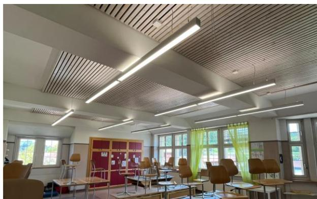
Der Lichtwert von unter 300 Lux wurde auf über 500 Lux angehoben und trotzdem gibt es eine Energieeinsparung von bis zu 64 %. Die hocheffizienten und langlebigen LED-Leuchten haben eine Lebensdauer von 70'000 Stunden. Die komplette Beleuchtungslösung ist made in Switzerland. Das heisst kurze Lieferfristen und schnelle Reaktion im Supportfall.
