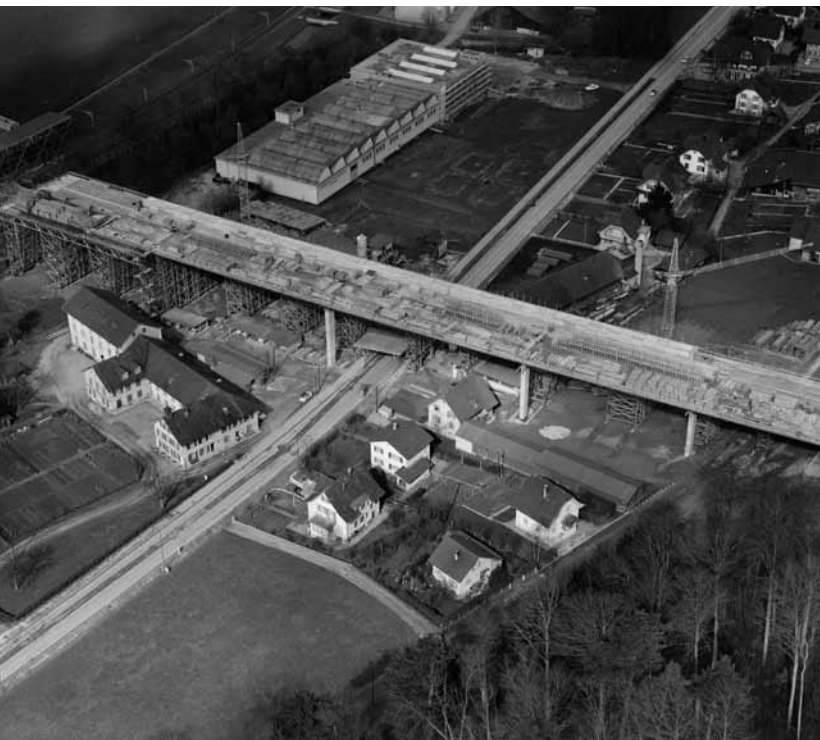
Der Aabachviadukt im Bau, 1963
