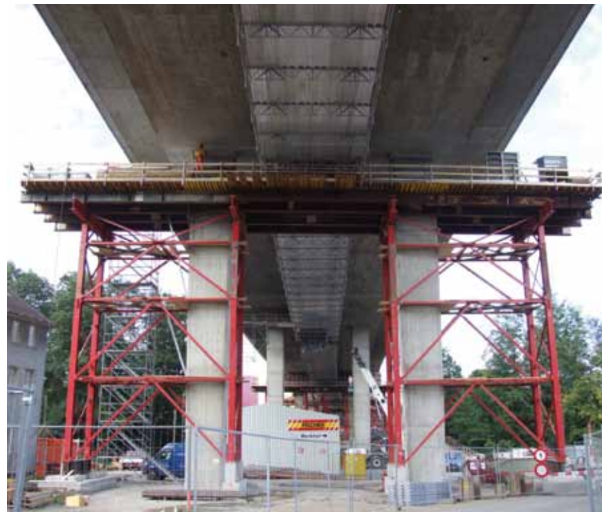
Arbeitsgerüst am Aabachviadukt im September 2010
