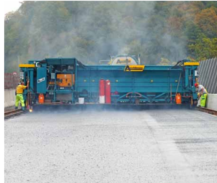
Belagseinbau auf dem Aabachviadukt
